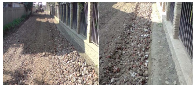
Hình 4. Ảnh hưởng của BTXM vỡ 150-300 mm đến tính đồng nhất của lớp móng [10]
