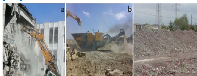
Hình 1. Quá trình phá dỡ và nghiền phế thải xây dựng
